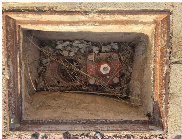
Fotografías: Detalle de estado de hidrantes en área industrial
