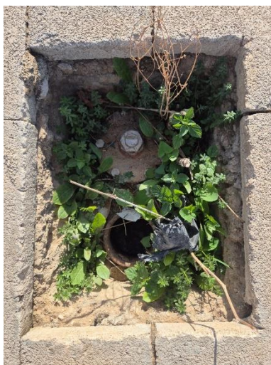
Fotografías: Detalle de estado de hidrantes en área industrial
